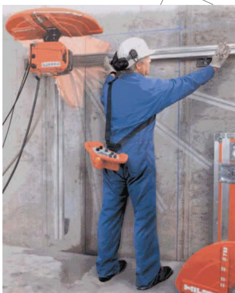
Σχήμα 2 - Κοπή τοίχου με δισκοπρίονο επί τροχιών καθοδήγησης
